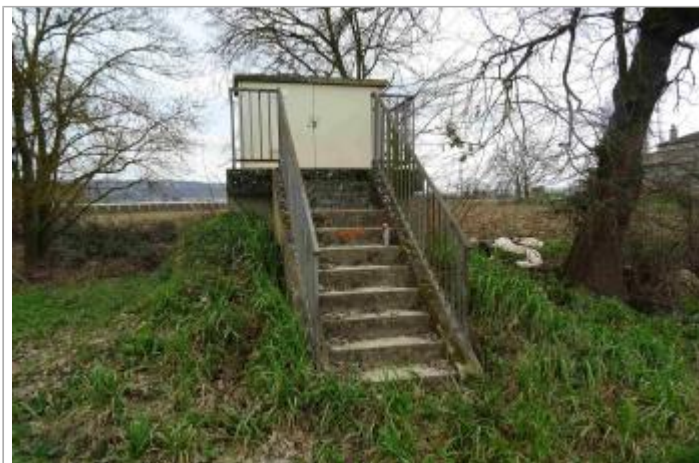
Vue du site - Photo Géosphair
