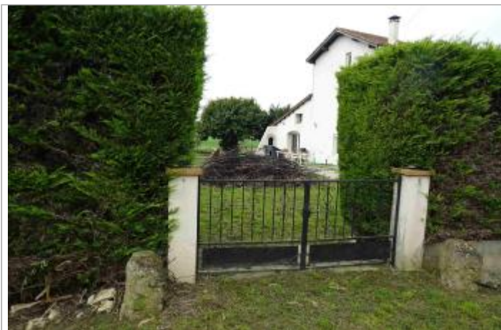
Vue du site - Photo Géosphair
