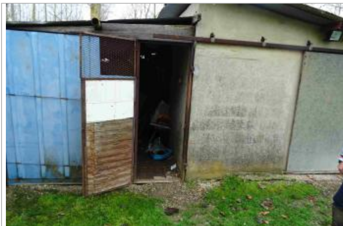
Vue du site - Photo Géosphair
