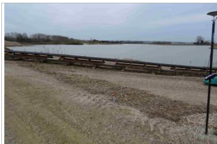
Vue du site - Photo Géosphair
