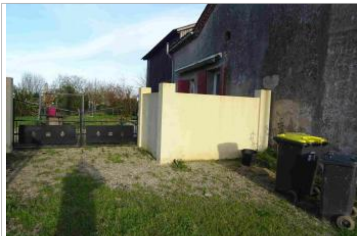
Vue du site - Photo Géosphair
