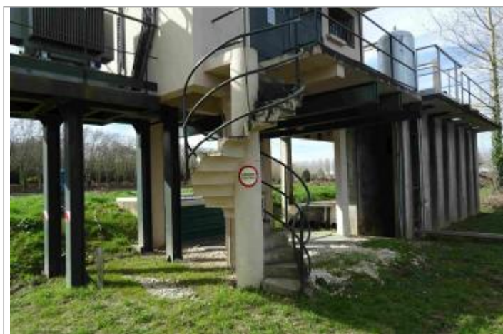
Vue du site - Photo Géosphair
