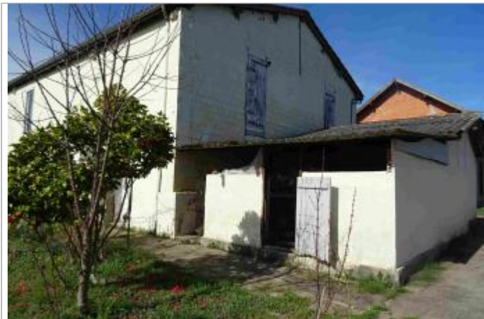
Vue du site - Photo Géosphair
