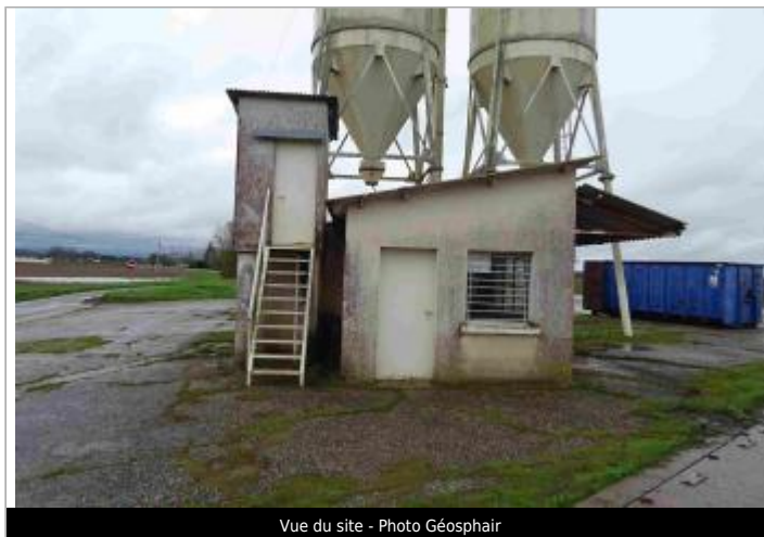
Vue du site - Photo Géosphair
