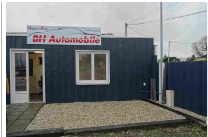
Vue du site - Photo Géosphair
