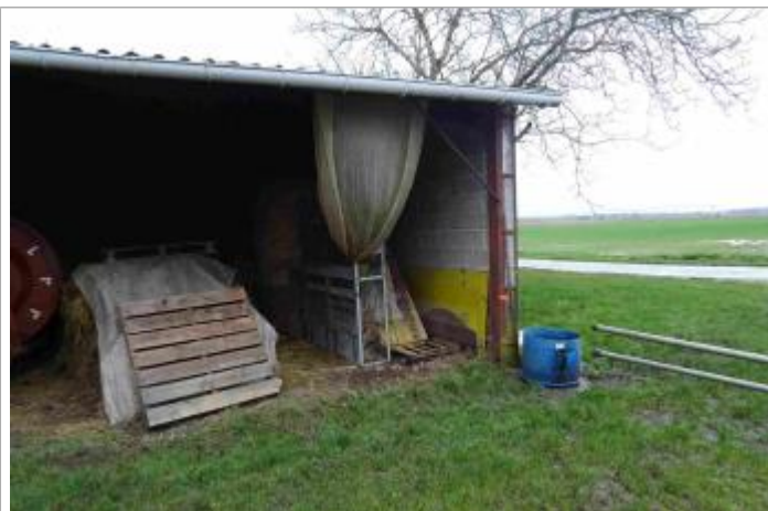
Vue du site - Photo Géosphair
