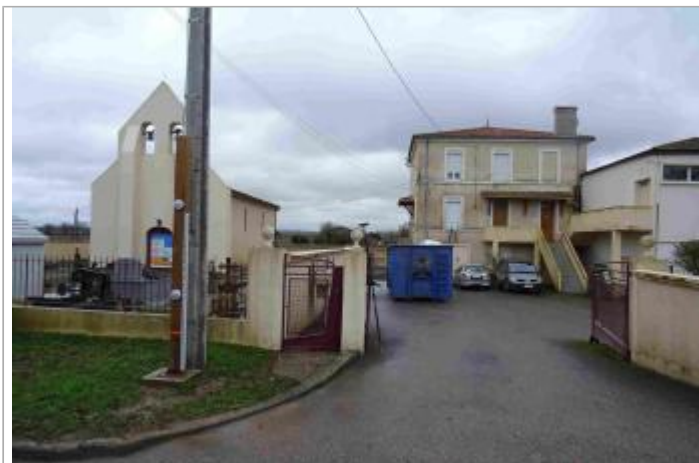
Vue du site - Photo Géosphair
