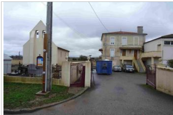
Vue du site - Photo Géosphair
