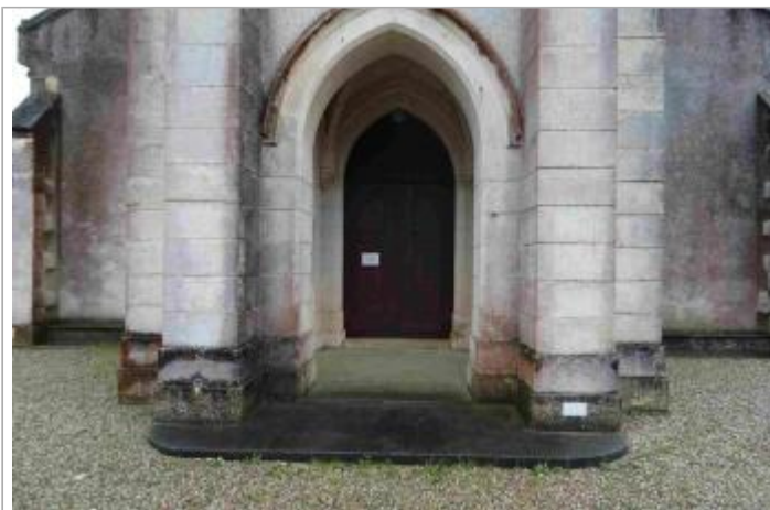
Vue du site - Photo Géosphair
