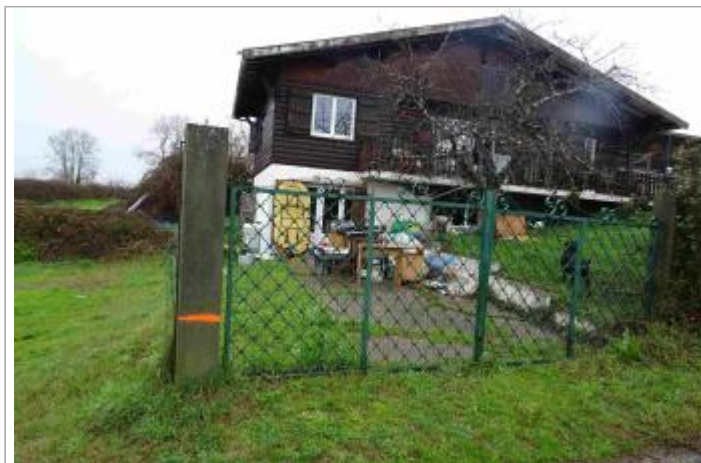
Vue du site - Photo Géosphair
