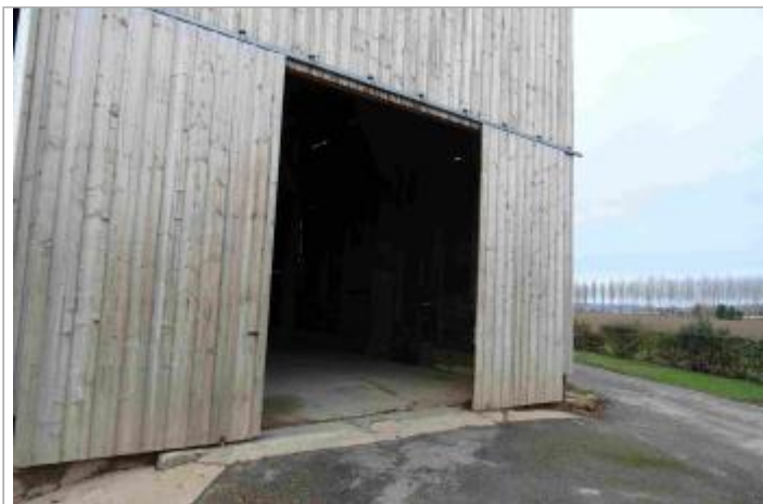
Vue du site - Photo Géosphair
