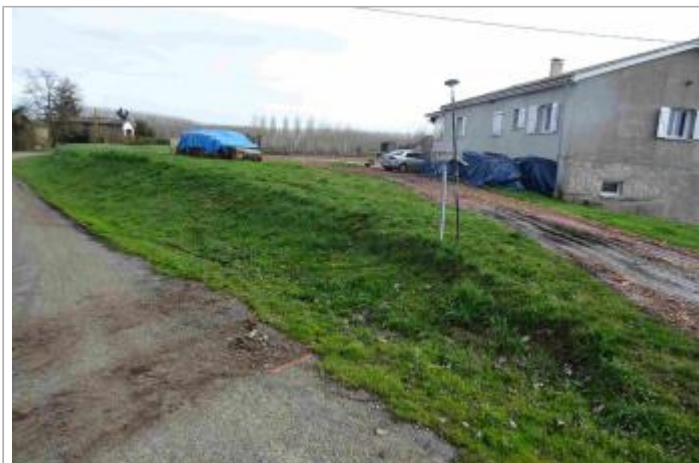
Vue du site - Photo Géosphair
