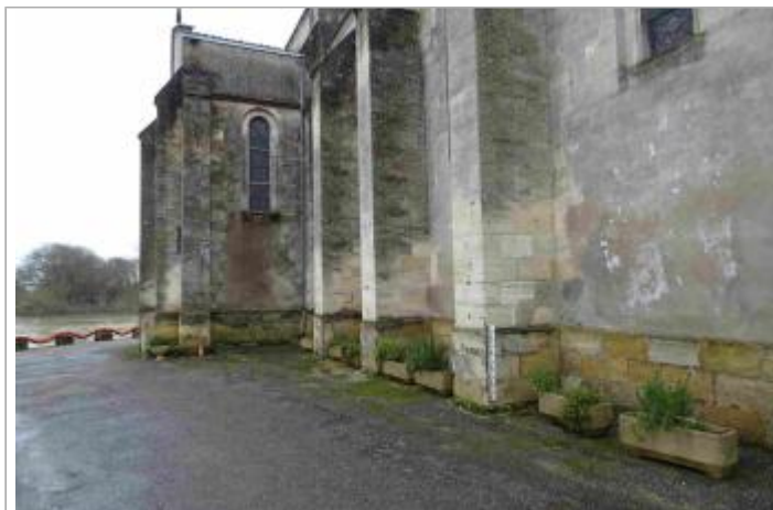
Vue du site - Photo Géosphair
