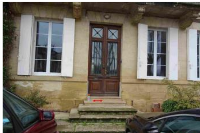
Vue du site - Photo Géosphair
