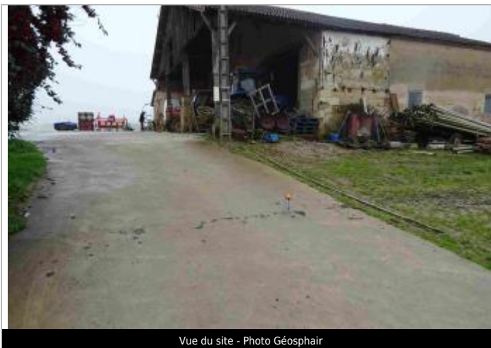
Vue du site - Photo Géosphair
