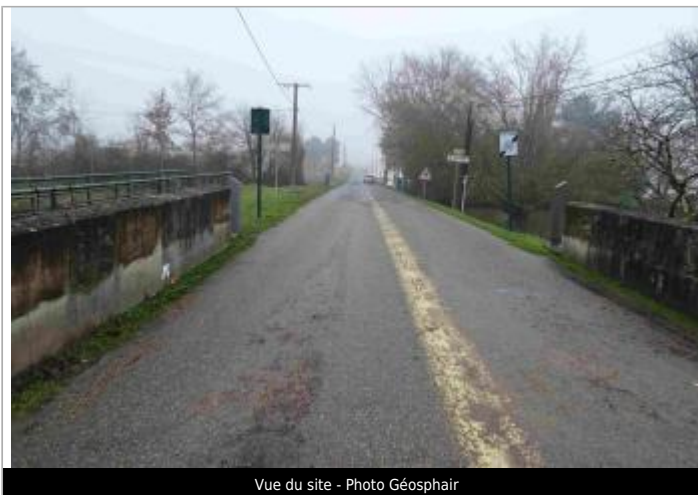
Vue du site - Photo Géosphair
