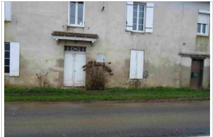
Vue du site - Photo Géosphair
