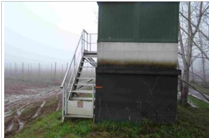
Vue du site - Photo Géosphair
