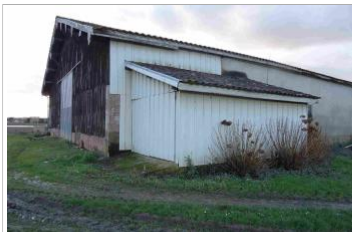
Vue du site - Photo Géosphair
