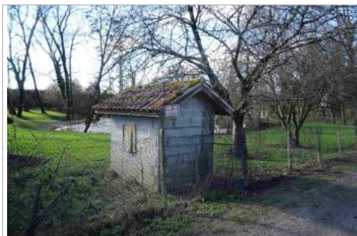
Vue du site - Photo Géosphair
