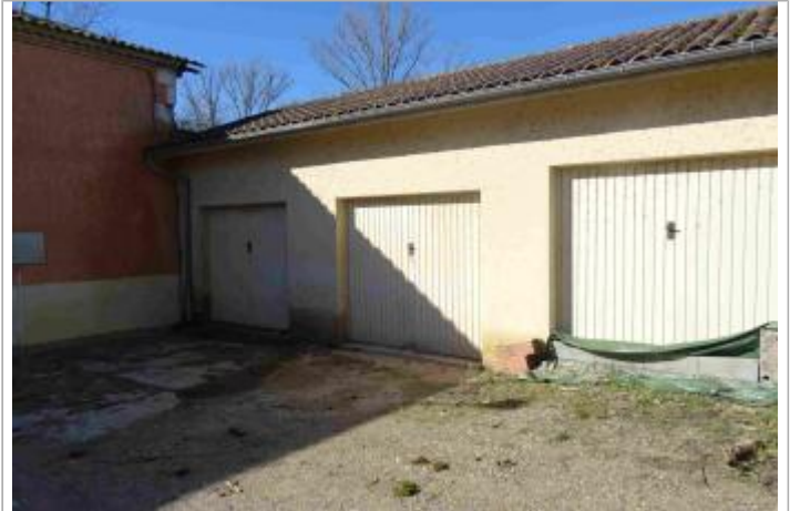
Vue du site - Photo Géosphair
