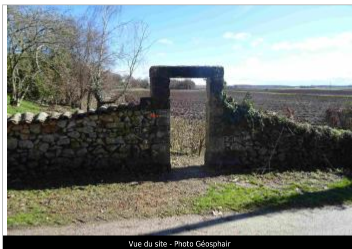
Vue du site - Photo Géosphair
