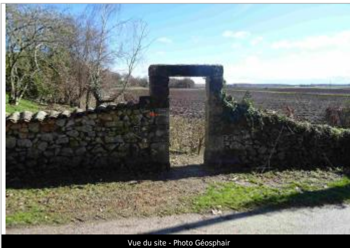
Vue du site - Photo Géosphair
