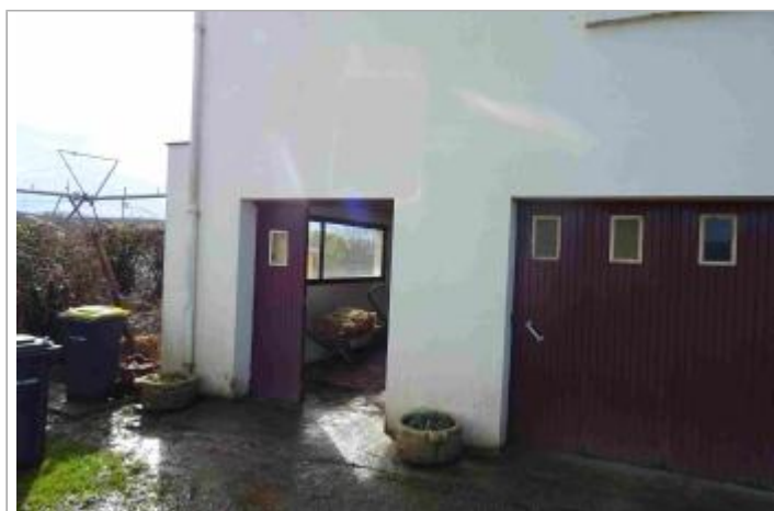
Vue du site - Photo Géosphair
