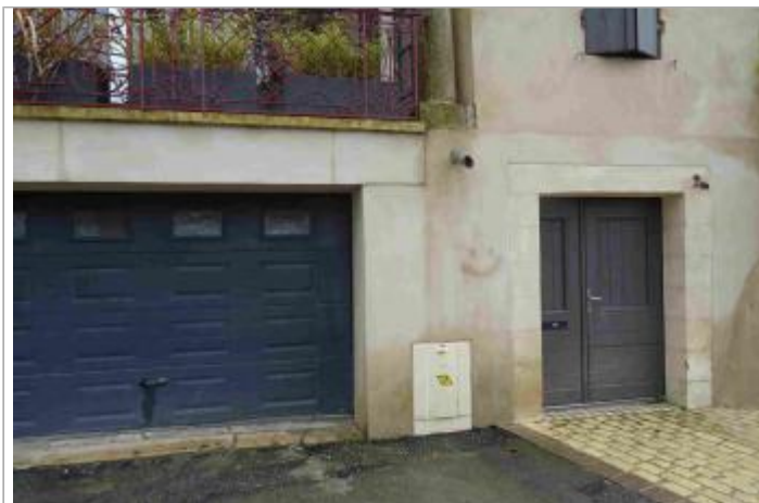
Vue du site - Photo Géosphair
