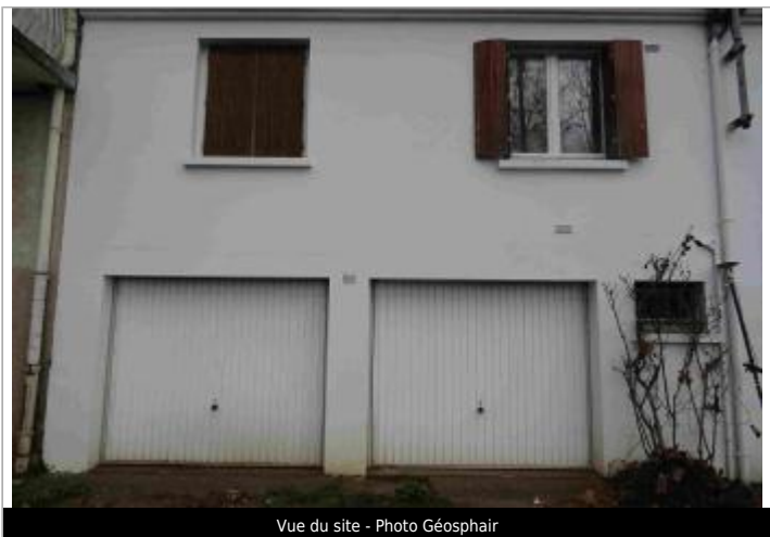
Vue du site - Photo Géosphair
