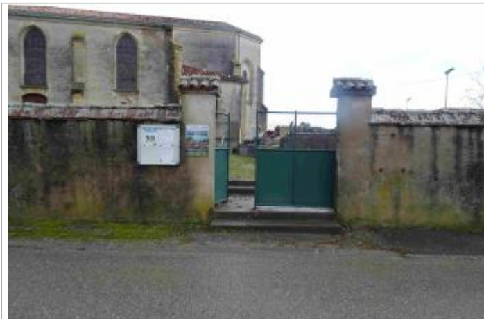
Vue du site - Photo Géosphair
