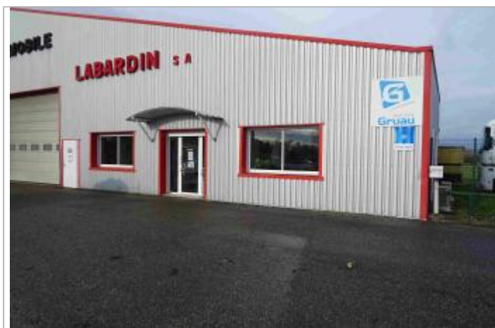
Vue du site - Photo Géosphair
