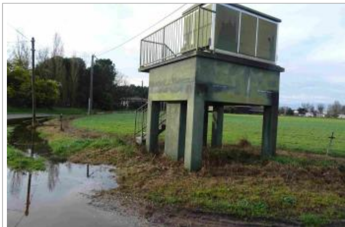
Vue du site - Photo Géosphair
