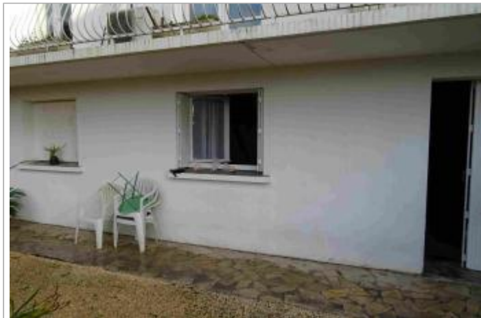
Vue du site - Photo Géosphair
