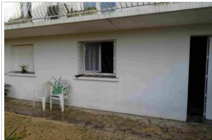
Vue du site - Photo Géosphair
