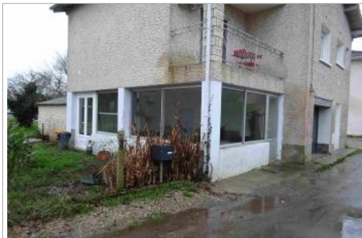
Vue du site - Photo Géosphair
