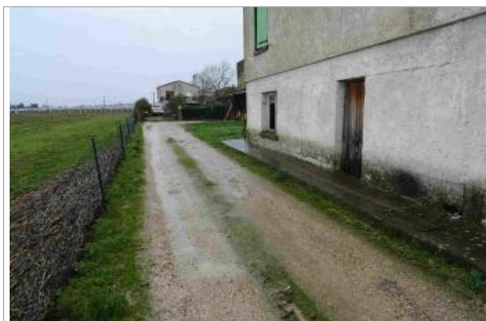
Vue du site - Photo Géosphair
