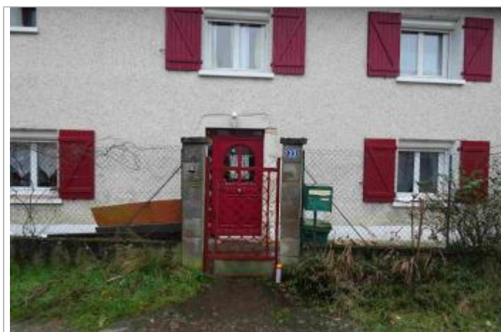
Vue du site - Photo Géosphair
