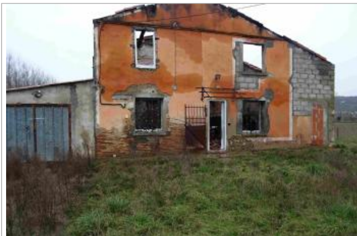
Vue du site - Photo Géosphair
