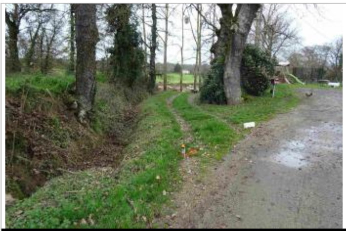
Vue du site - Photo Géosphair
