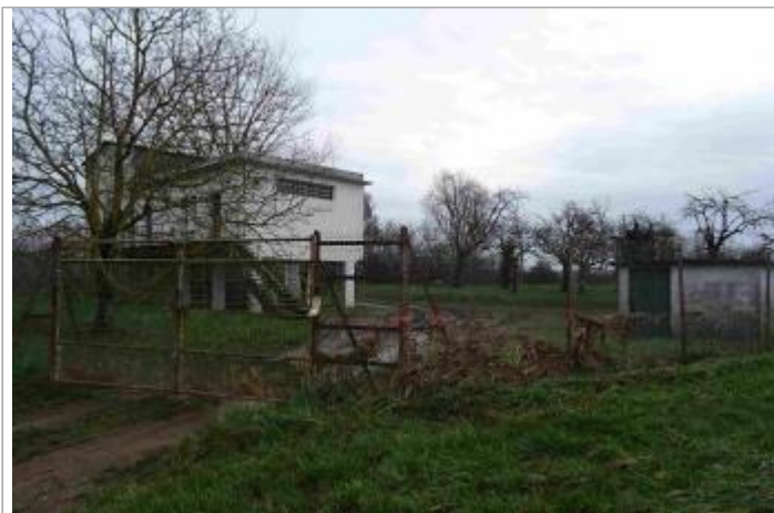
Vue du site - Photo Géosphair
