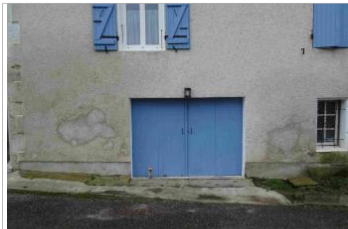
Vue du site - Photo Géosphair
