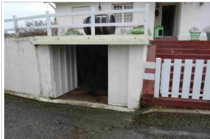
Vue du site - Photo Géosphair
