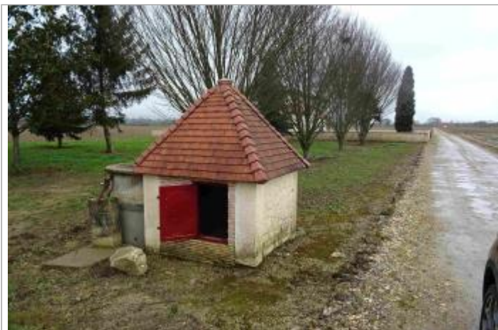
Vue du site - Photo Géosphair
