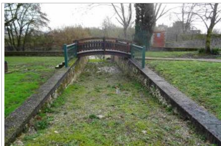
Vue du site - Photo Géosphair
