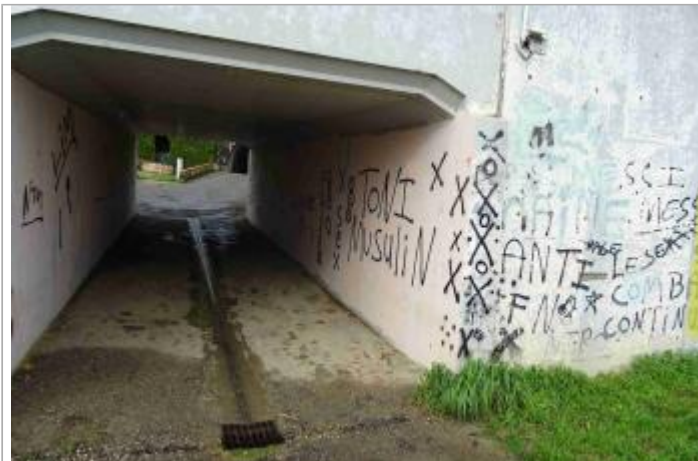
Vue du site - Photo Géosphair
