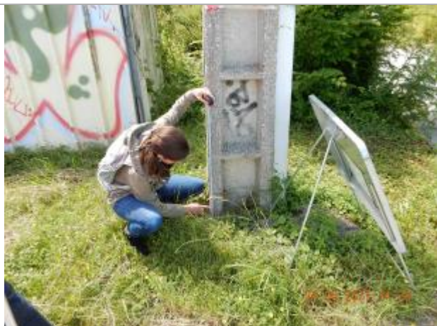
Laisse de crue sur poteau EDF à 8 cm/sol
