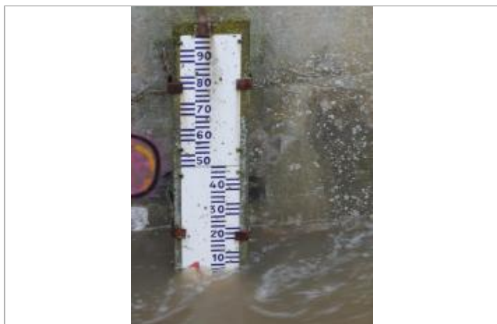
laisse de crue sur échelle limnimétrique (94 cm/sol)
