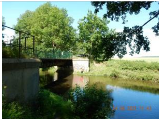
Chemin d'Inval, échelle limnimétrique.
