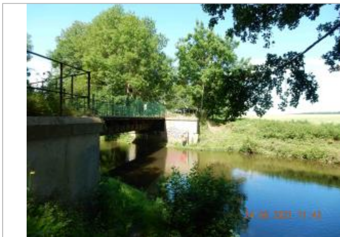
Chemin d'Inval, échelle limnimétrique.
