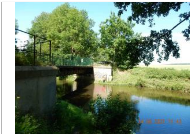
Chemin d'Inval, échelle limnimétrique.
