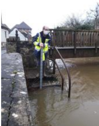
Laisse de crue à 6 cm en dessous de la deuxième marche en partant du haut de l'escalier
