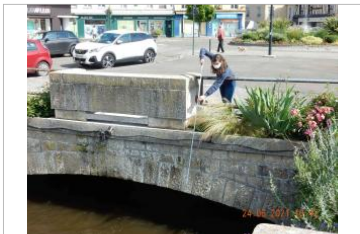
Laisse de crue à 110 cm en dessous du muret du pont
