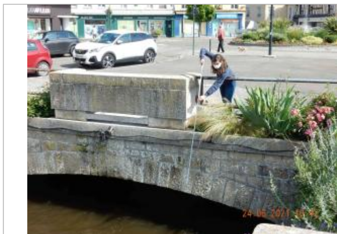
Laisse de crue à 110 cm en dessous du muret du pont
